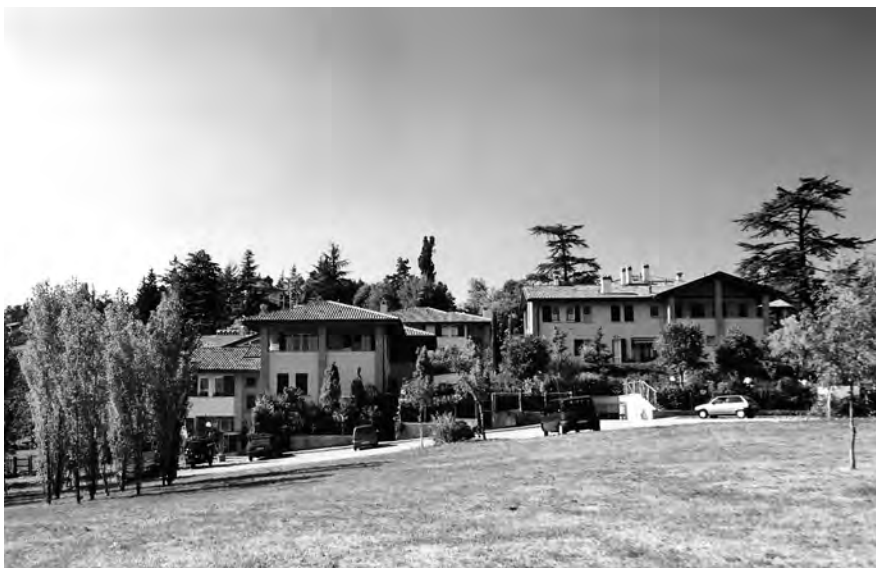
7. Complesso 'Bel Poggio' in via Pilati, 1995-2000. Sul sito di una vecchia scuola e, prima ancora, del podere della madre dell'architetto, gli edifici sono ispirati all'edilizia rurale tradizionale (foto Gioia Cacciari).
