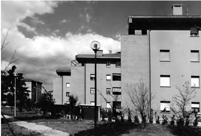
5. Edifici su via Kennedy e via Torreggiani, 1995-1999. Vanno notati il profilo movimentato del complesso e il dialogo fra i materiali. L'obiettivo è togliere monotonia e mantenere alta la qualità del dettaglio (foto Gioia Cacciari).
