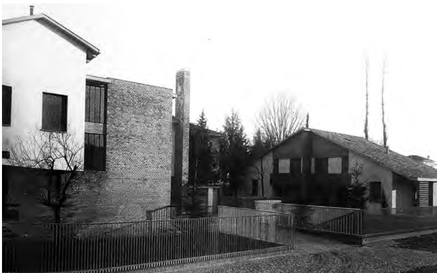
2. Complesso di 5 villette unifamiliari in via Torino a S. Lazzaro. La foto risale al periodo della costruzione alla fine degli anni Cinquanta.
