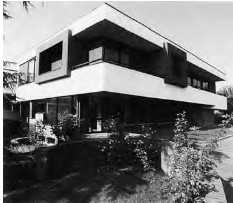
11. Palazzina uffici dell'insediamento industriale Eurodent, 1976. La cornice a rilievo al centro del prospetto ne rompe l'uniformità, conferendo all'insieme eleganza e personalità (foto Gioia Cacciari).
